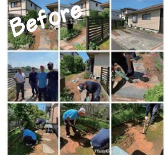
10年前の固まる土をすべて撤去して、歩行用の飛び石を再配置。したがて植栽部を仕切り、アプローチ部は路盤工事で転圧整地した後に、防草シートを2重張り、川砂利)を敷きこみました。
