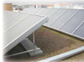
ソーラーコレクター(太陽熱集熱器)
